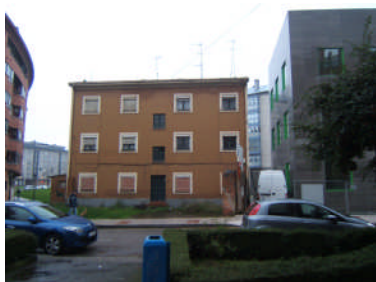
Estado previo a la demolición
