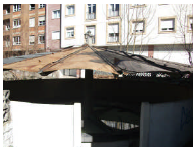
Estado previo a la actuación
