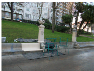
Ejecución de los trabajos
