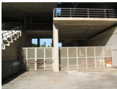
Estado previo a la actuación
