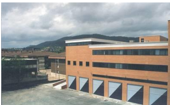
Edificio del Servicio de Extinción de Incendios
